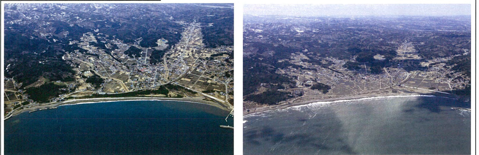
被災前状況 H22.3.9 撮影
