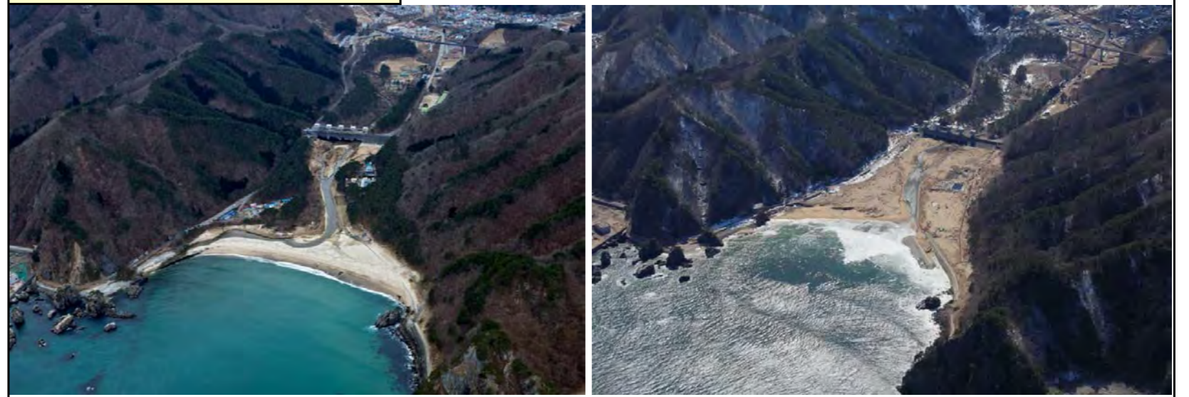
被災前状況 H22.3.9 撮影
