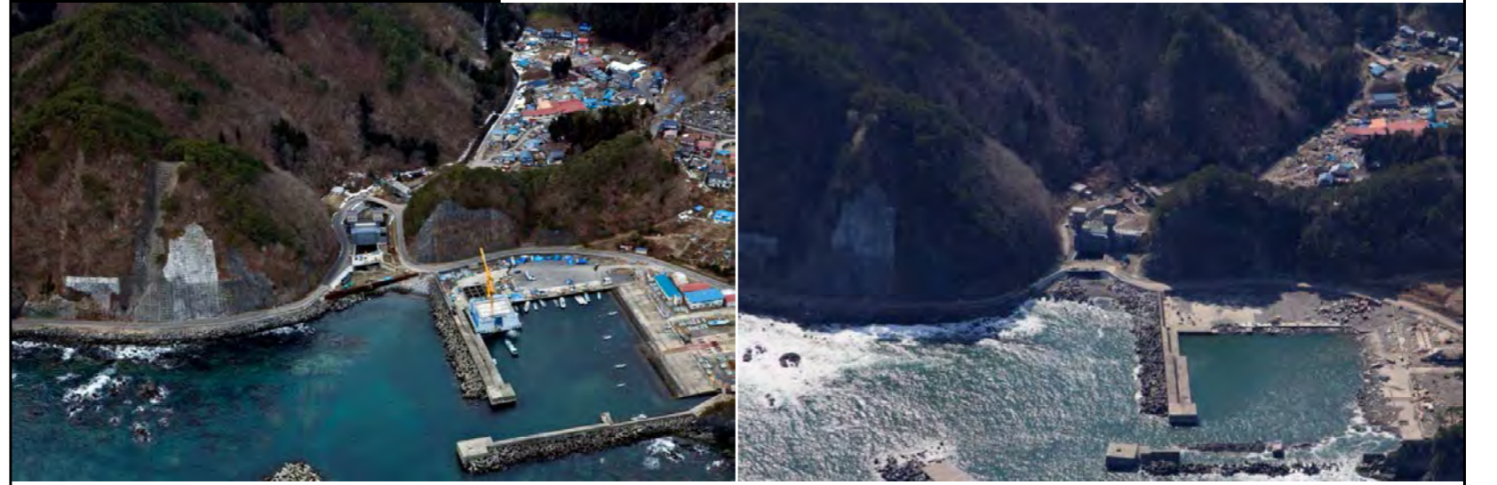
被災前状況 H22.3.9 撮影
