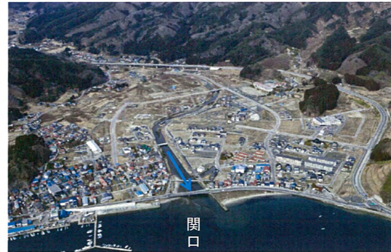
被災前状況 H22.3.9 撮影
