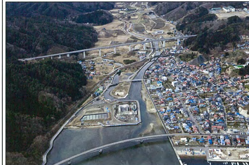
被災前状況 H22.3.9 撮影
