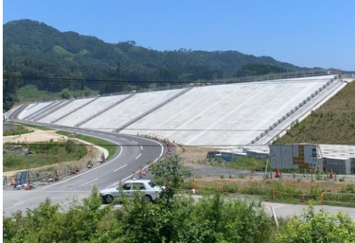
完成写真(全景終点側より)
