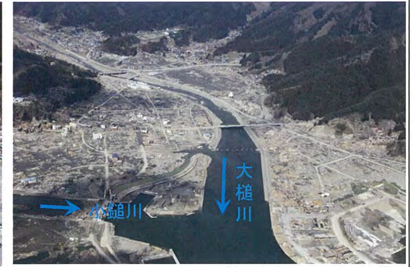
被災後状況 H23.3.29 撮影
