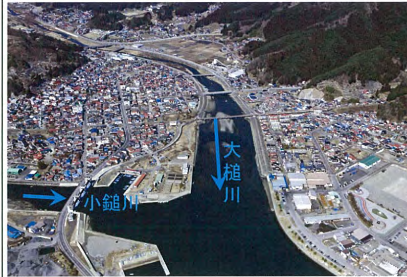
被災前状況 H22.3.19 撮影
