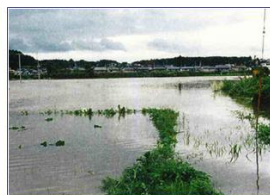
平成14年7月台風6号による岩崎川の増水及び浸水被害の状況
