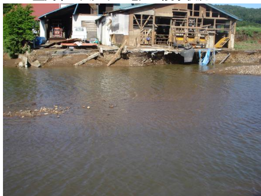
盛岡市玉山区川崎地区の家屋被災状況
