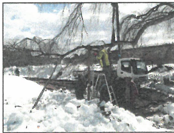
ユニックを使って支柱を建てる
