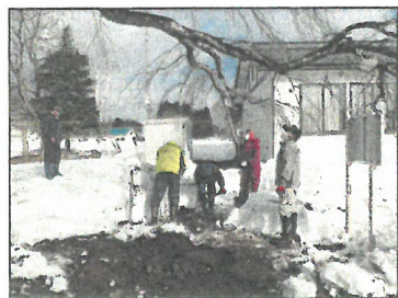
雪かきと地面の掘削
