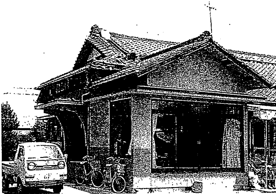
写真-16 落下危険物 (瓦) (ランクA)
