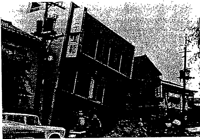
図-7 全体沈下が1mを超える被害例
