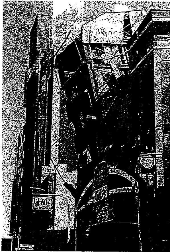
写真-4 著しく傾斜した建築物
