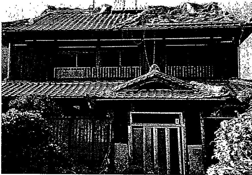
写真-7 建築物の1階の傾斜 (ランクB)
