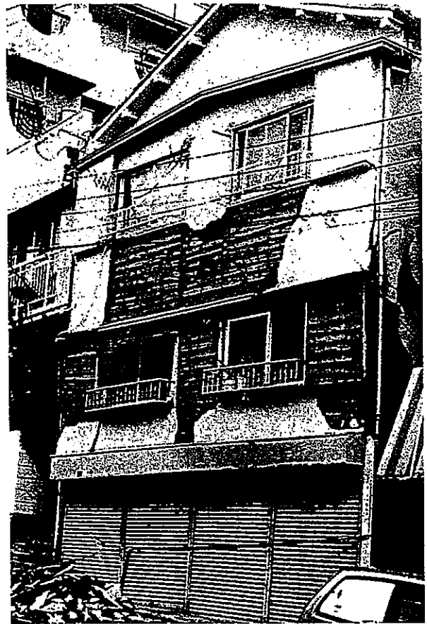
写真-13 壁の被害 (外壁) (ランクC)
