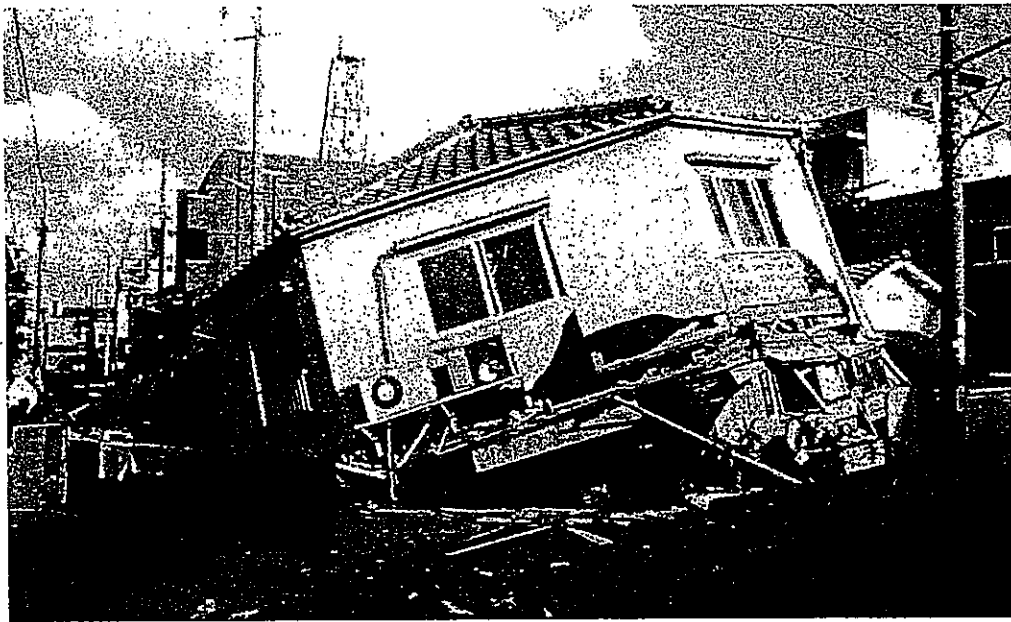
写真-2 一見して危険と判断される
