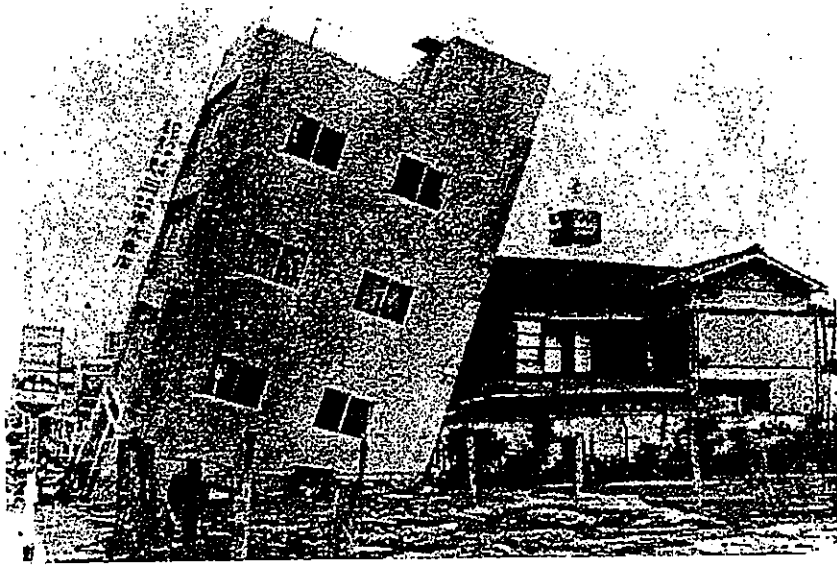
図-6 建物の全体傾斜が2度以上の被害例
