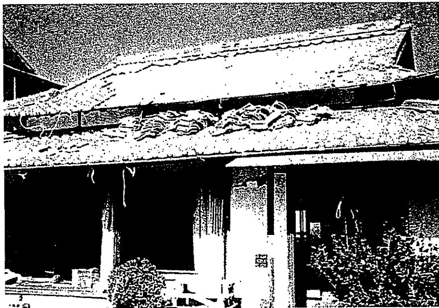
写真-17 落下危険物 (ランクB)
