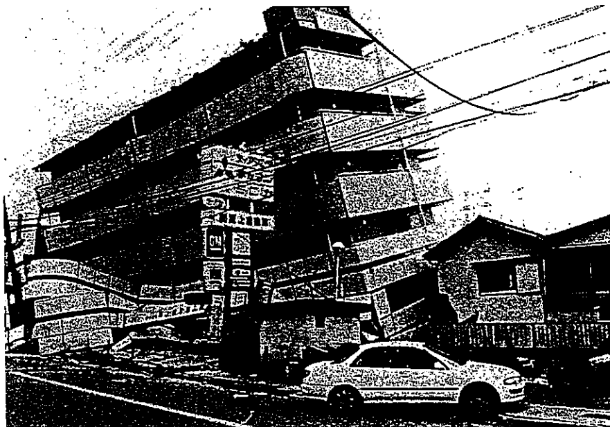
写真-3 低層階で落階した建築物
