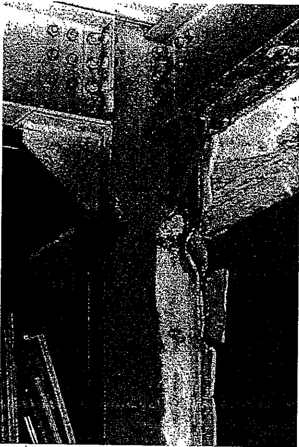
写真-13 局部座屈を生じた柱
