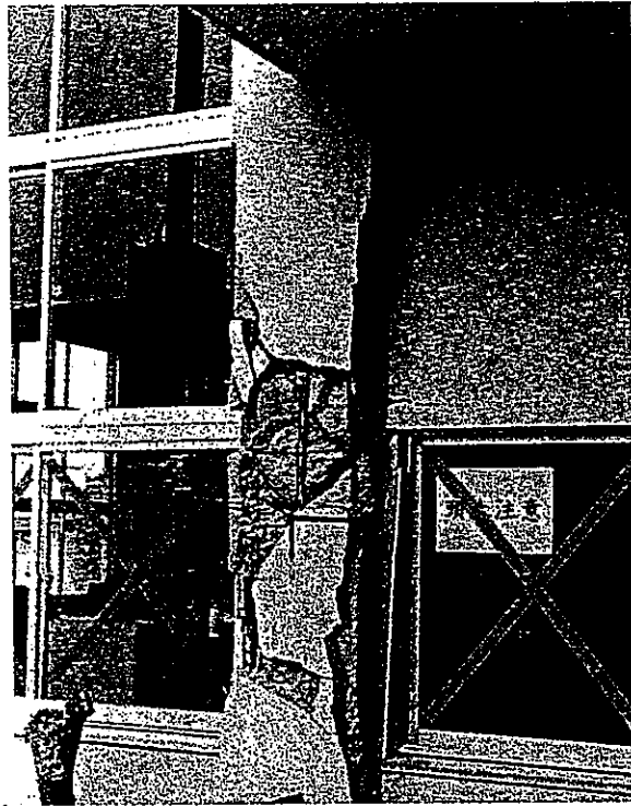
(c) コンクリートの剥落が激しく、鉄筋が広範囲にわたって露出している。 (鉛直方向の変形がある場合には損傷度Vとなる。)
