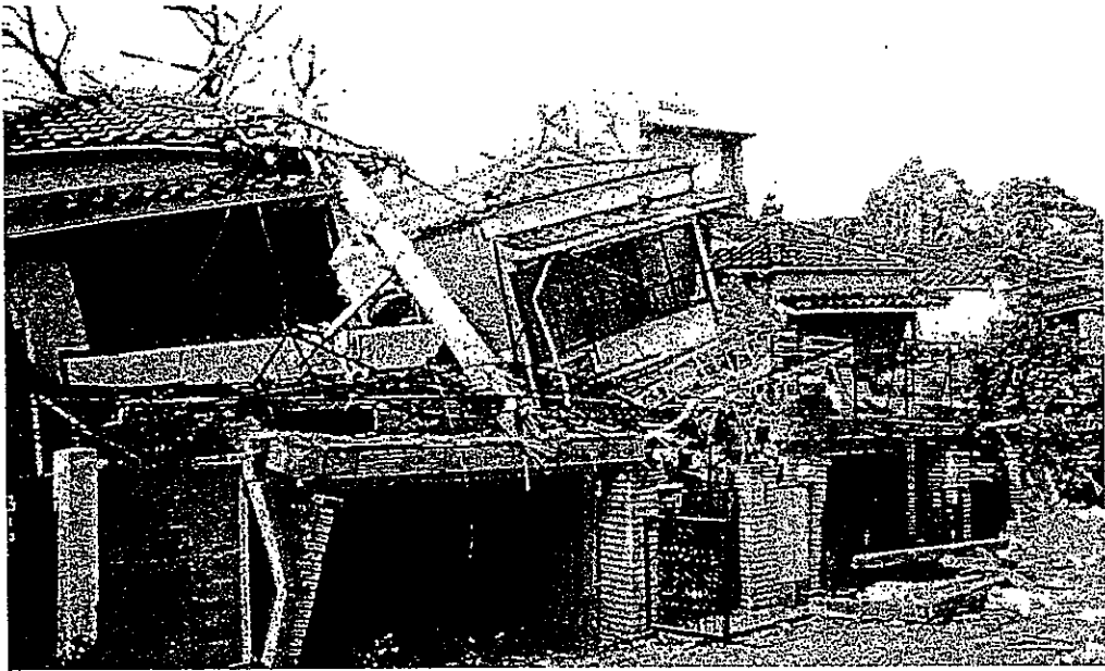
写真-1 一見して危険と判断される
