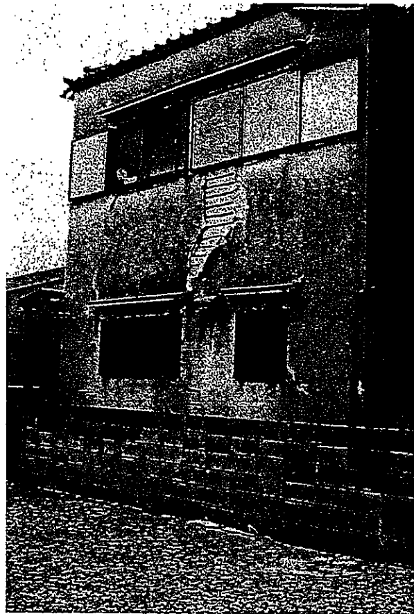
写真-11 壁の被害 (外壁) (ランクB)
