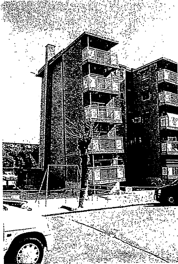
写真-10 不同沈下のため傾斜した集合住宅
