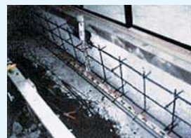
鉄筋コンクリート打ち増しによる基礎の補強
