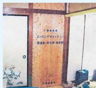
構造用合板取付による壁の補強
