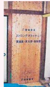
構造用合板の設置
