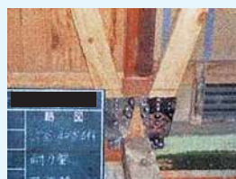
補強金物取付による壁の補強
