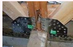
補強金物の設置
