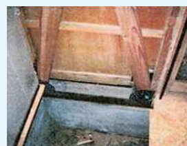
補強金物取付による壁の補強
