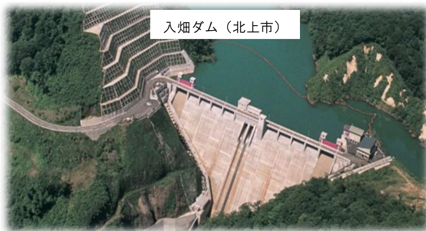
■写真 2 県保有インフラ施設の例■
