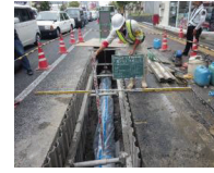
水道基幹管路の耐震化(高知県高知市)
