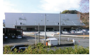
物流拠点の高台移転や分散化(静岡県)
