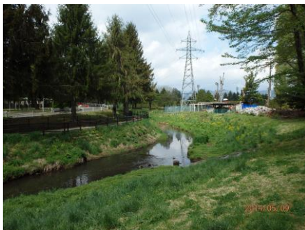
写真7 木賊川多自然川づくり（滝沢市）
