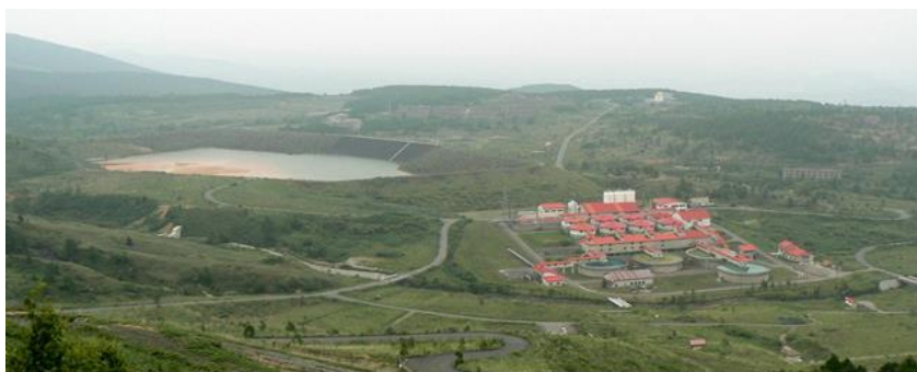
写真10 旧松尾鉦山坑廃水対策（新中和処理施設と貯泥ダム）
