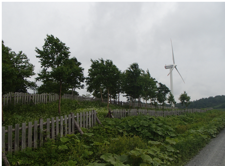
防風柵設置状況
