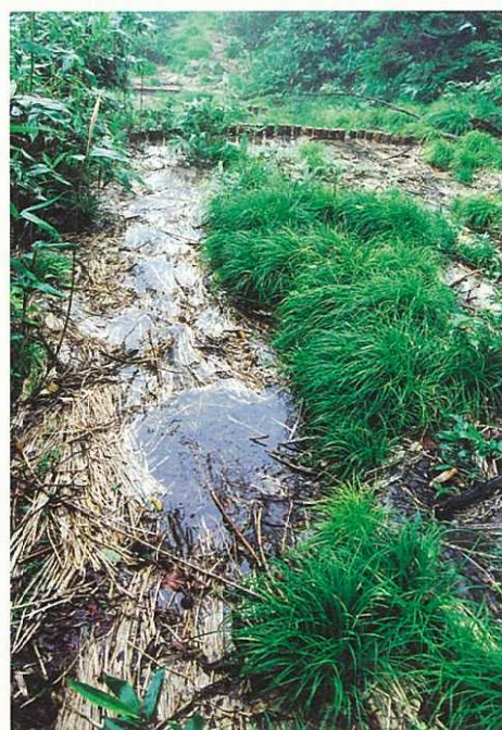
写真8-3 むしろ張りした斜面を流下する雨水(1999年8月)
