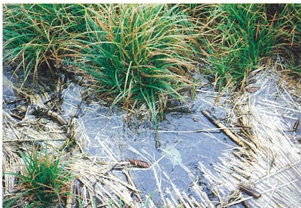
写真9-1 雨水のためにわらが流された わら被覆工（1999年8月）
