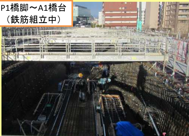
P3橋脚 (コンクリート打設状況)
