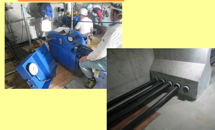
ケーブル緊張作業
