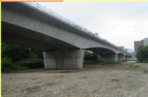
P4橋脚～A1橋台
