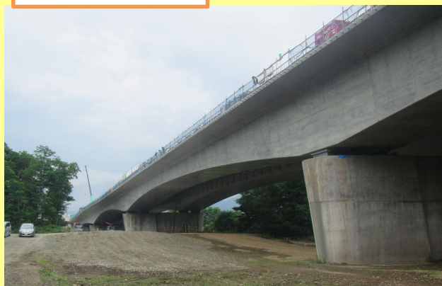
P4橋脚～A2橋台
