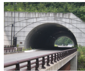
境鼻トンネル
