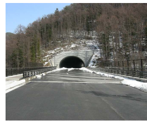
曾利田トンネル
