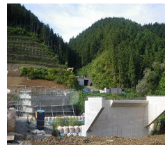
戸中橋(工事中)
