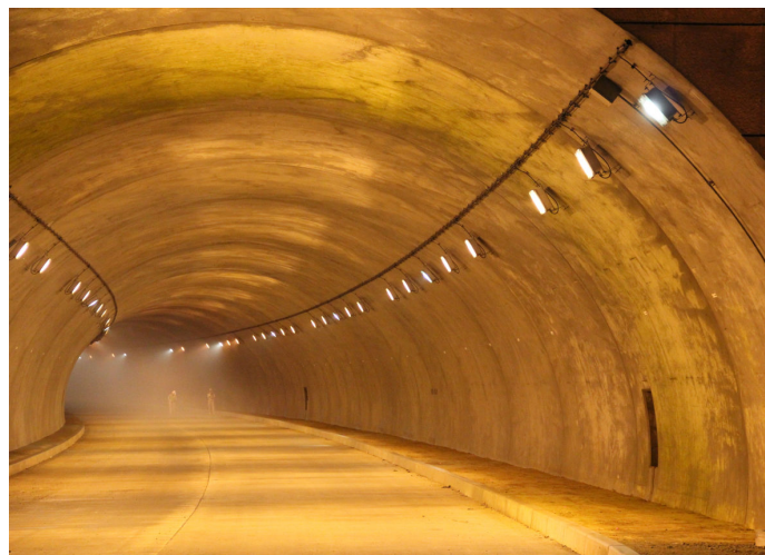
水沢トンネル
