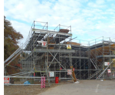
洗沢橋(工事中)
