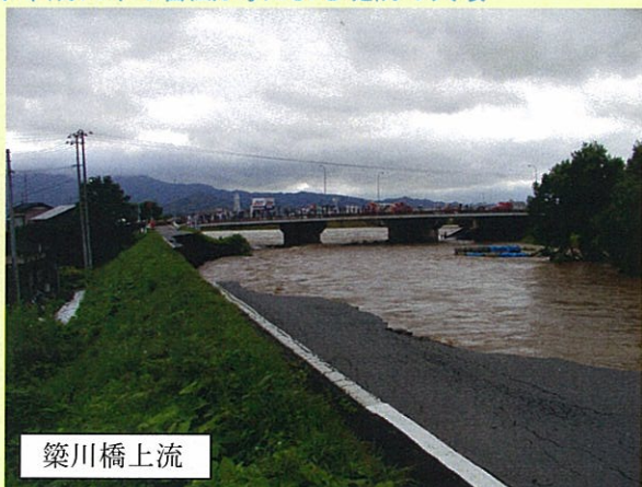
◆平成14年の台風6号による堤防の欠壊
