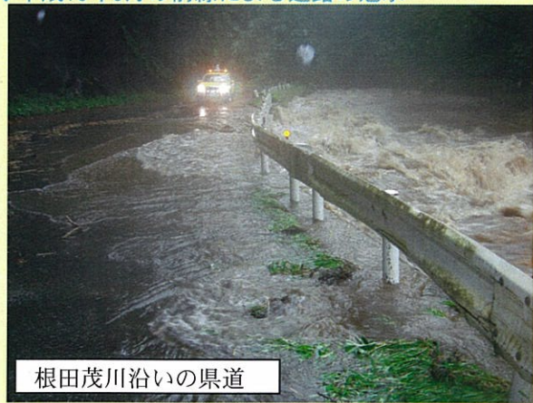
◆平成19年9月の前線による道路の冠水
