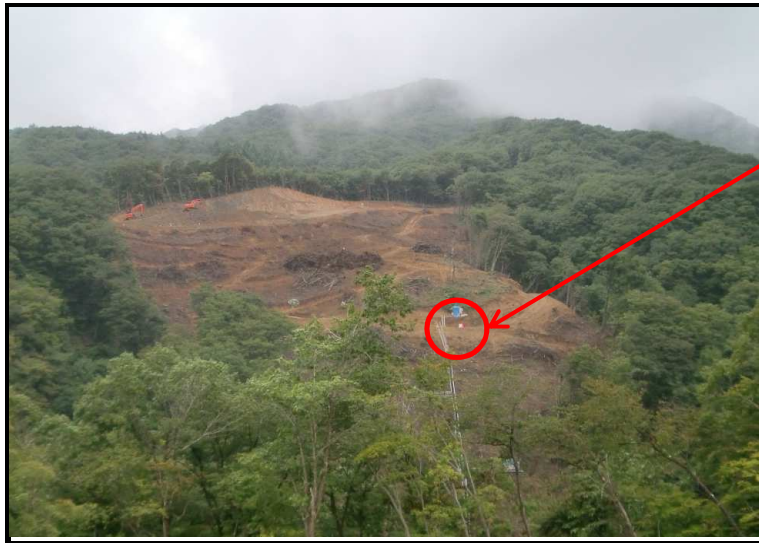
右岸工事用道路 掘削状況(対岸から撮影)
