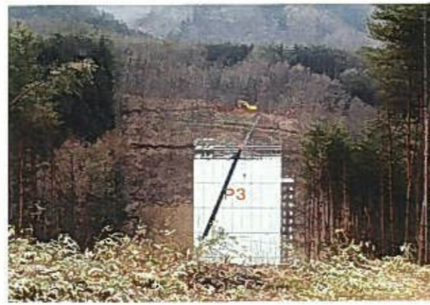
A2橋台側より撮影(H14.5月現在)
