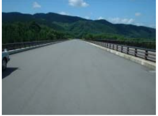
(2) 築川道路 5 号橋から盛岡方向を望む
