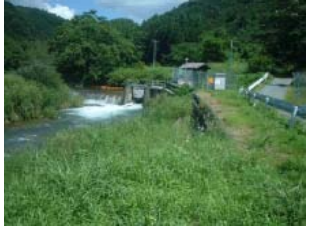
(8) 盛岡市水道取水堰
