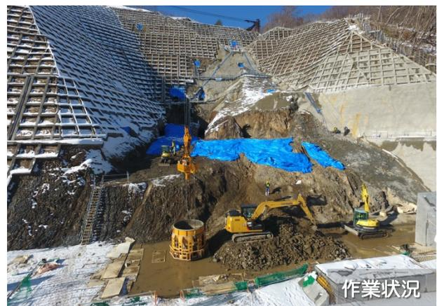
風化防止のために岩盤の打設範囲に吹き付けていたモルタルの撤去作業をしています。撤去後、仕上げの掘削作業、岩盤の清掃作業を行い、春からのコンクリート打設に備えます。
