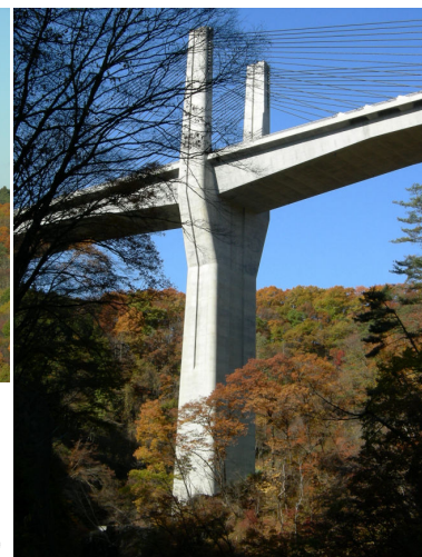
付替え国道9号橋
