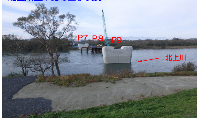
北上川左岸側の工事状況
