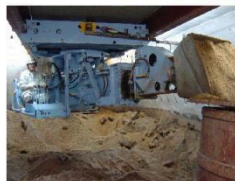
ケーソンショベル 天井に反力をとり掘削するニューマチックケーソン工法用の掘削機
