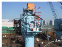
マンロック 高気圧作業室と地上間で人の出入りに使用する設備
