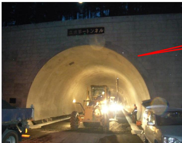
トンネル内での路盤施工状況です。
