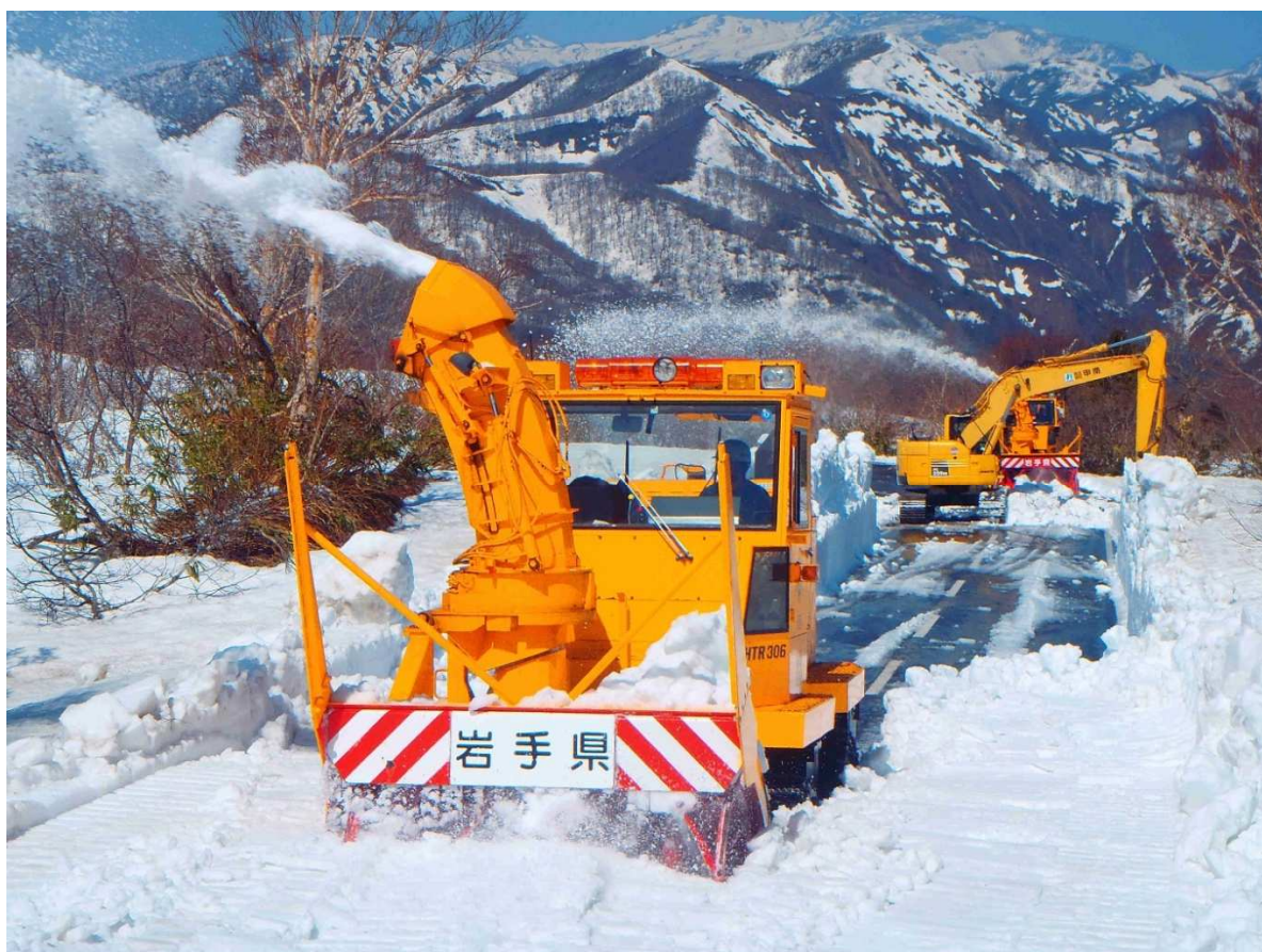
一般国道 342 号須川地区 春先除雪の作業状況
