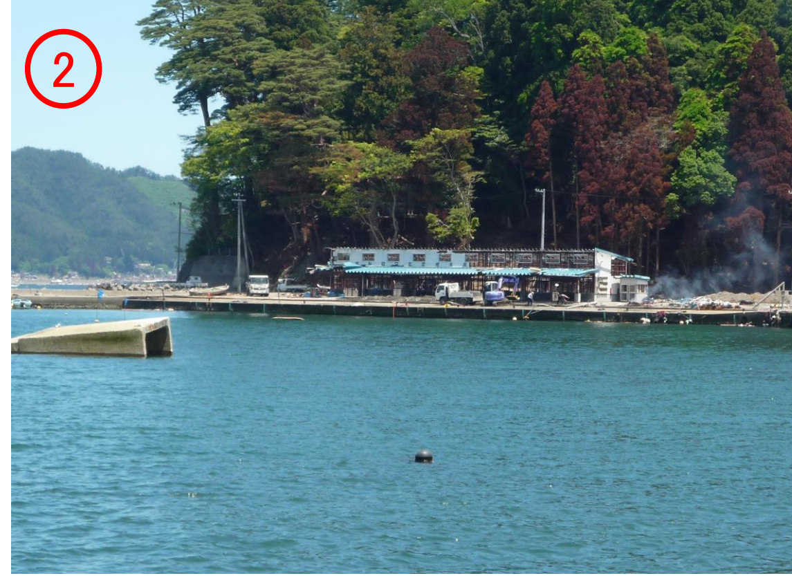
(物揚場:沈下、背後養殖用作業施設被災)
