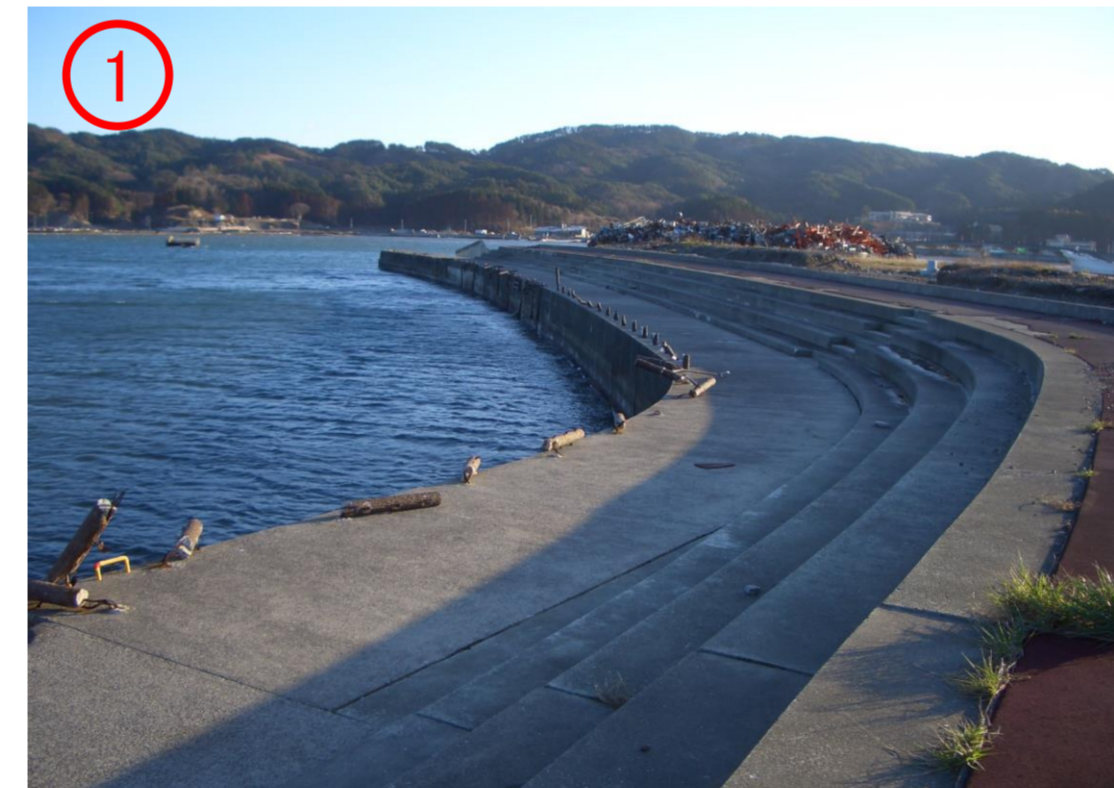
(手前護岸: 沈下等、奥の防波堤: 倒壊)
