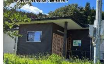
④保全対象の公共施設 赤浜自治会館(避難所)
