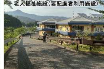
④保全対象の公共施設 老人福祉施設(要配慮者利用施設)
