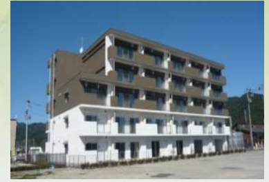
安渡アパート 23戸（災害） 〔平成30年12月 完成〕
