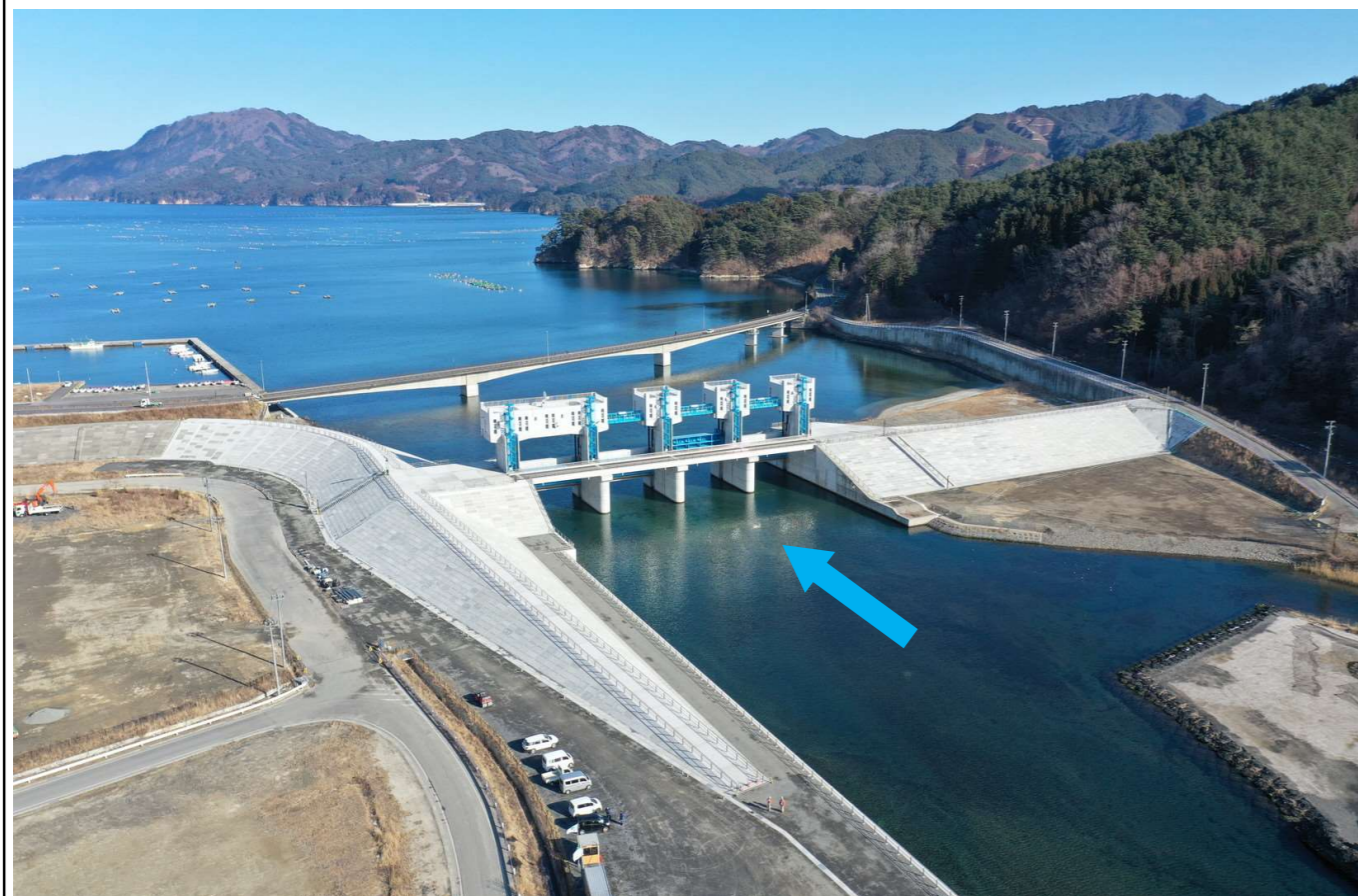
上空写真(上流側)
