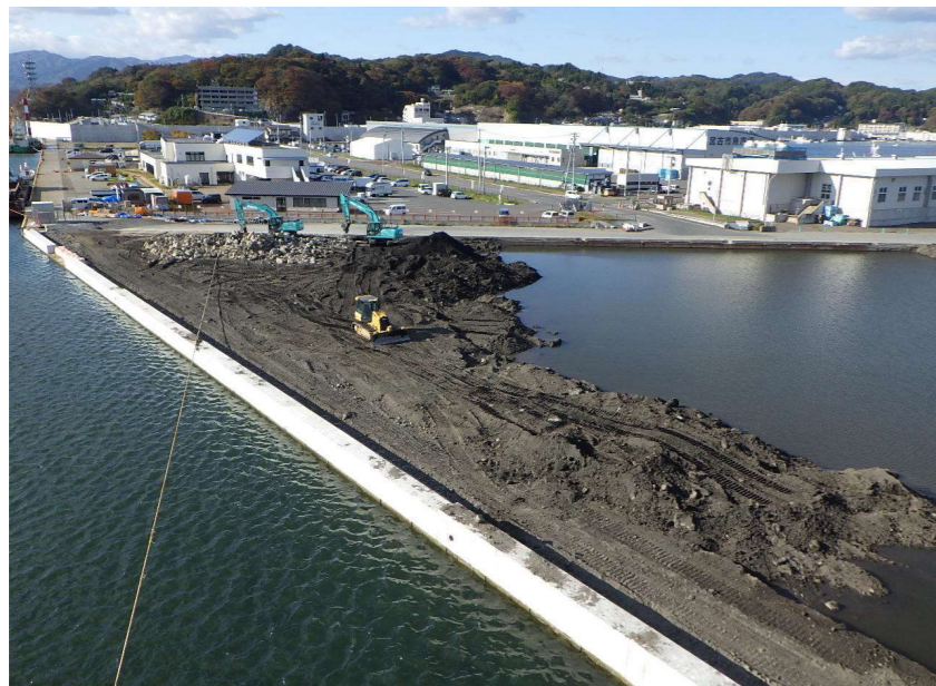
現在は埋め立てのための土砂投入をしています。写真は令和2年10月末撮影
