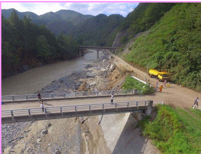
被災直後(H28.9.5・下流より撮影)
