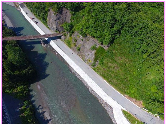
施工状況(H30.8.21・下流より撮影)
