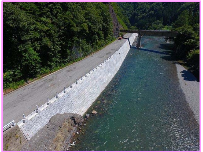
施工状況(H30.8.21・上流より撮影)
