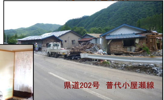
人家の被害状況
