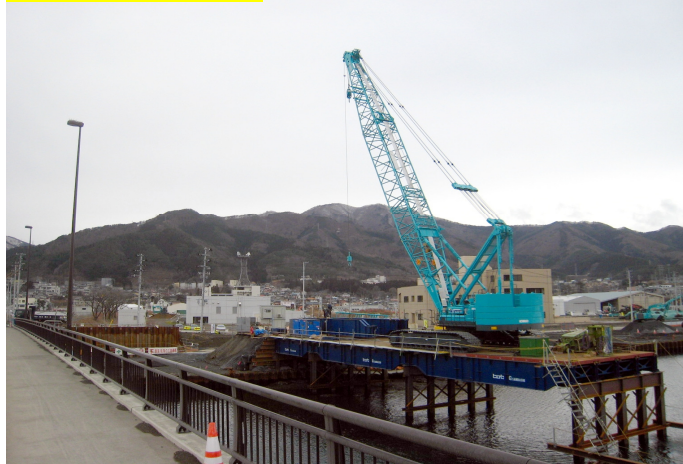
② 川口橋架替工事
