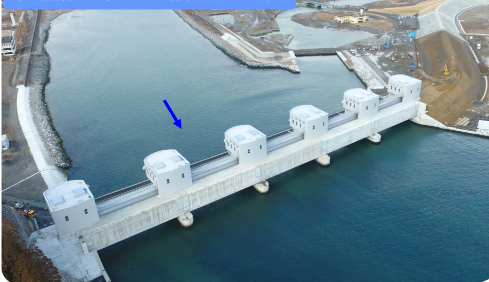
周辺整備状況（R2.2.28撮影） 下流より
