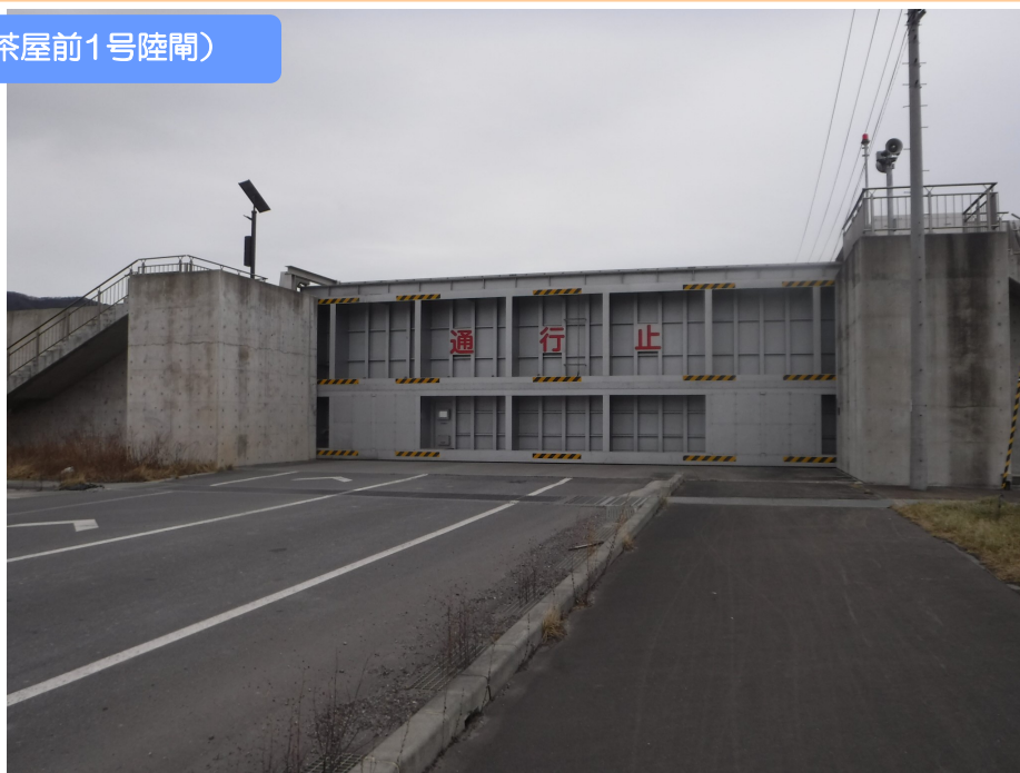
閉鎖状況（矢作水門）
