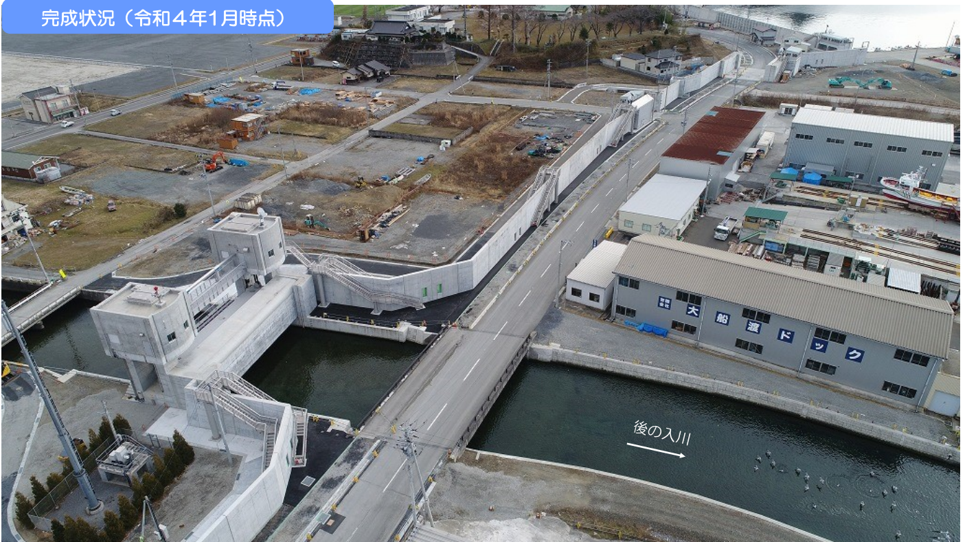
完成状況（令和4年1月時点）
