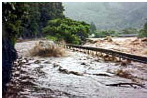
被害状況：一般国道 340 号
