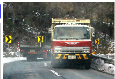
大型車のすれ違いが困難な道路幅員
