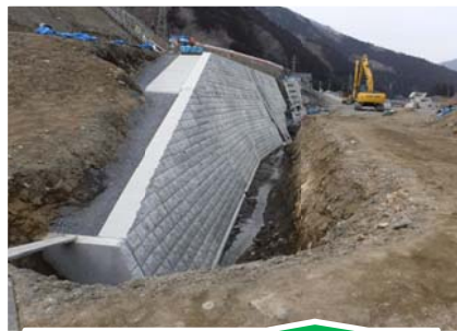
気仙川：火石工区その2
