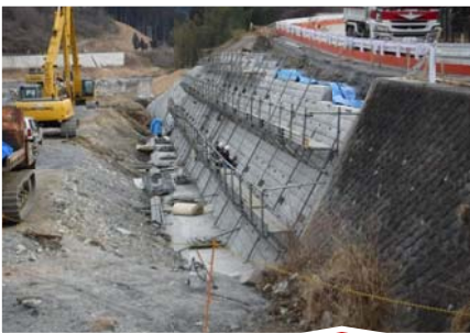
気仙川：火石工区その1
