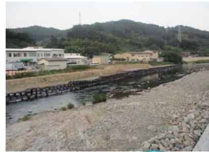
気仙川火石工区左岸実施中
