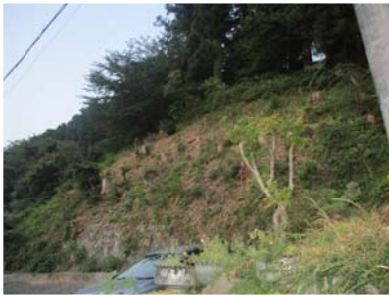
大崎急傾斜地崩壊対策
