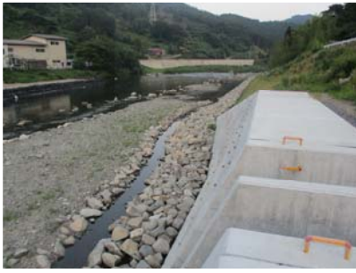
気仙川火石工区右岸完成
