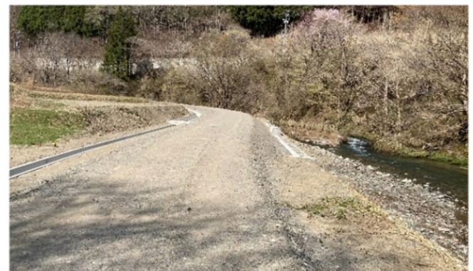
金成地区築堤の終点部
