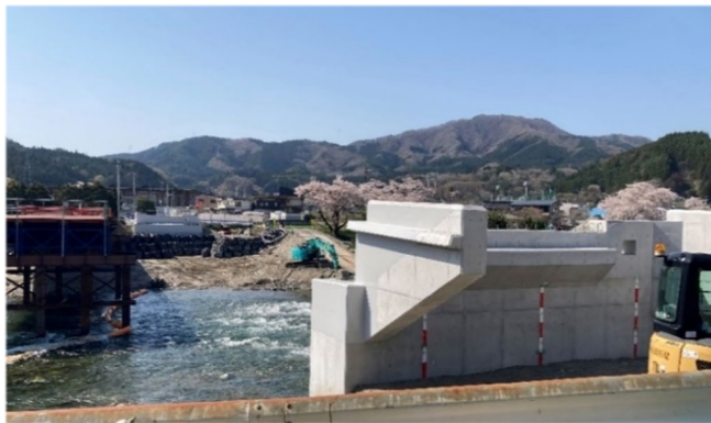
現在の工事現場の状況
