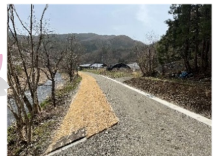
町道が堤防と兼用する区間
