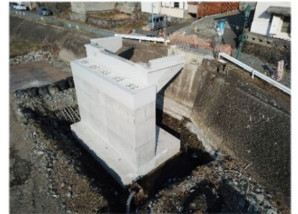
3月に完成した世田米駅側の橋台
