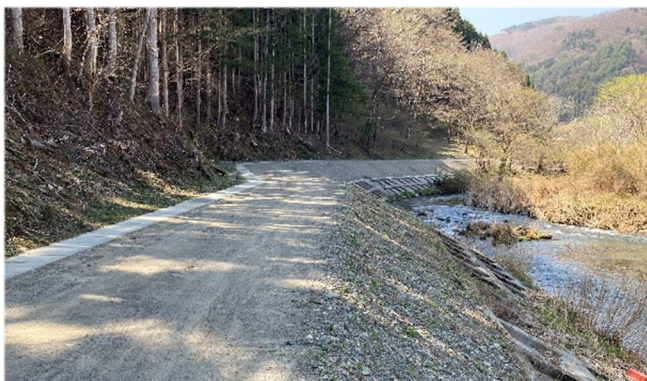
昨年度築堤を行った起点部
