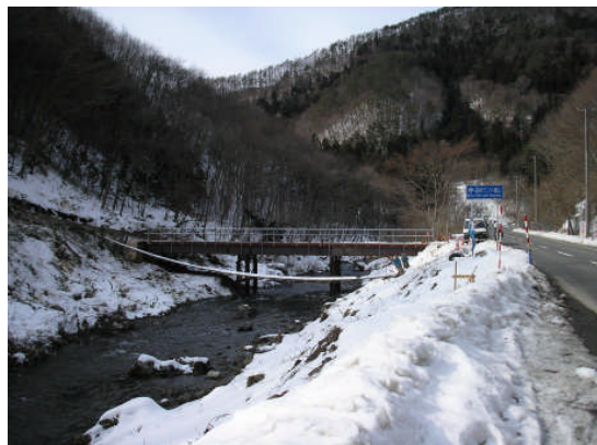
(仮橋工事完成)
