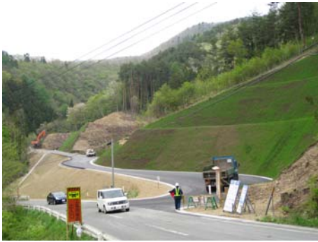
(1号工事用道路工事)
