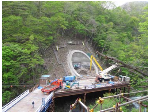
(付替国道1号橋下部工【P1】工事)
