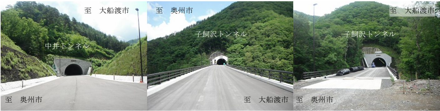
《 2工区の現在の状況 》
