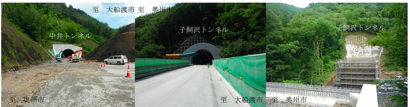
《2工区の現在の状況》
