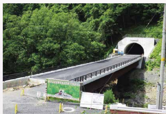
工事が進む国道281号案内トンネル
