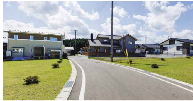
(※1) 道路や住宅など新たに整備された野田村新町地区
